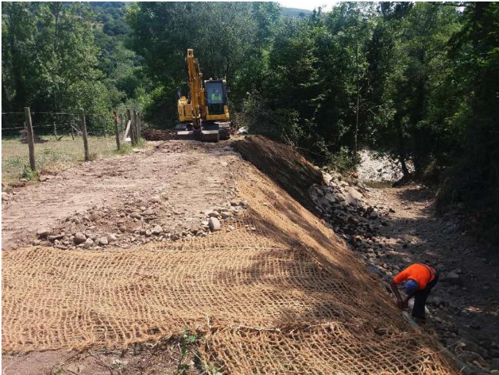
Durante: Técnicas de bioingeniería: colocación de la malla de coco
